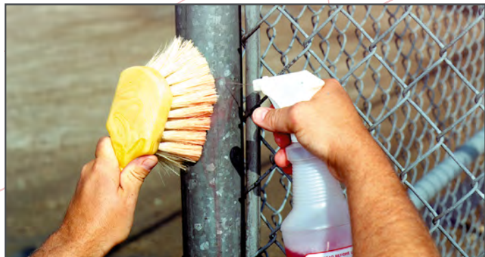
Limpieza del acero galvanizado
